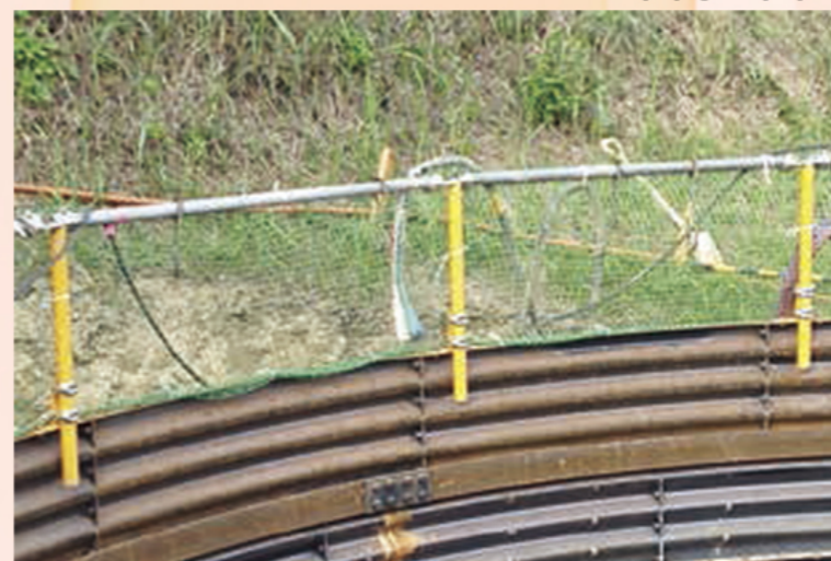
ライナープレート上部 手摺取付け金具
