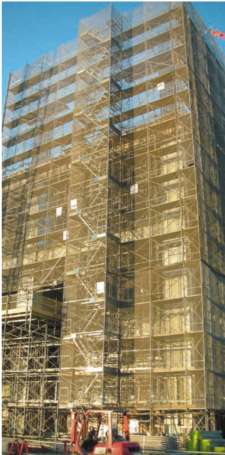
頭上にゆとりがあって、両側の手摺の付いたコンパクトな階段です。(踊場上クリアランス 1870mm)
