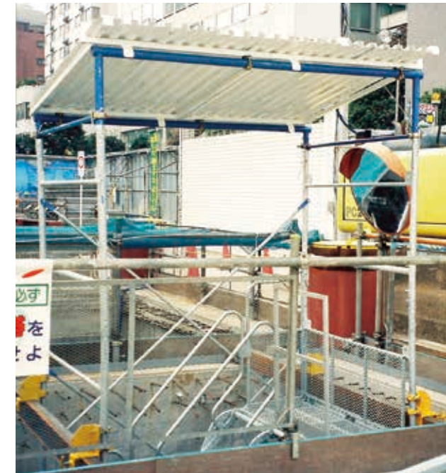
TK-300CB \square 150 \times 75 \times 6.5 \times 10 \times 3000 \ell ・クイックラダー吊り下げ設置用の支持梁 特徴：自重 56kg、人力 2 名での運搬や設置決め時の微調整が容易です。
