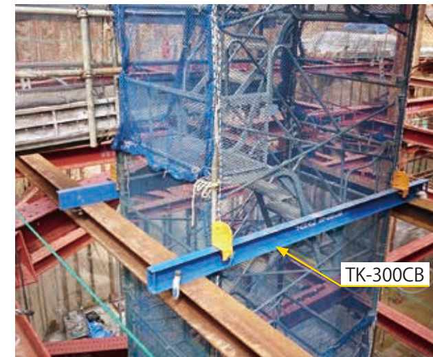
TK-300CB \square 150 \times 75 \times 6.5 \times 10 \times 3000 \ell ・クイックラダー吊り下げ設置用の支持梁 特徴：自重 56kg、人力 2 名での運搬や設置決め時の微調整が容易です。
