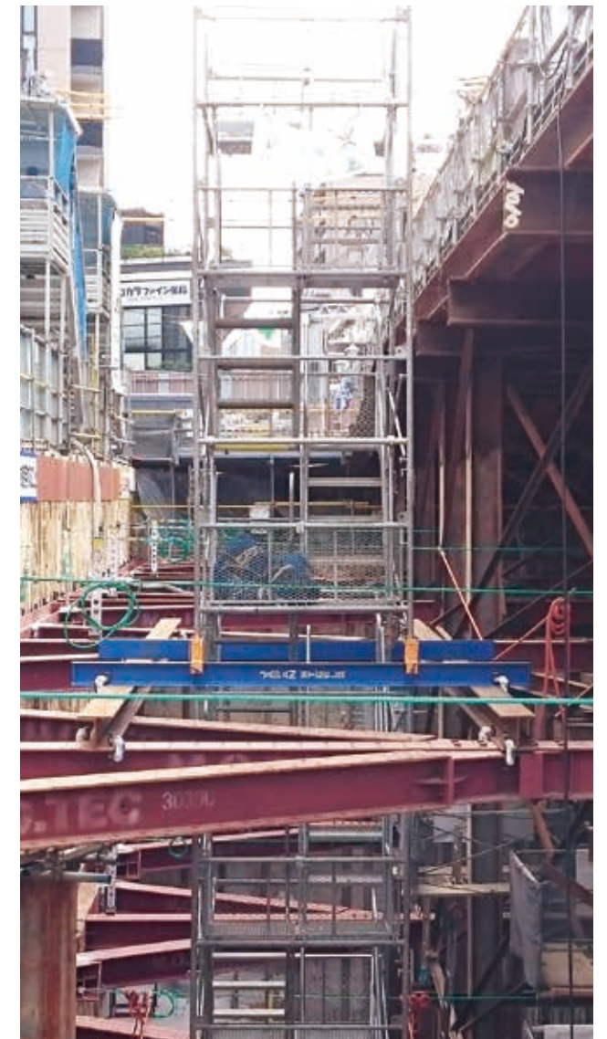
TK-300CB \square 150 \times 75 \times 6.5 \times 10 \times 3000 \ell ・クイックラダー吊り下げ設置用の支持梁 特徴：自重 56kg、人力 2 名での運搬や設置決め時の微調整が容易です。
