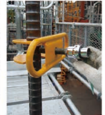
『押さえボルトを締める』 (ラチェット21mm)
