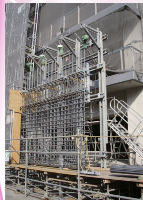
壁配筋ユニット P269~270
