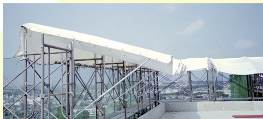
仕上用最上部 縦枠雨養生シート P355~356
