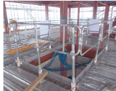
シーズ管ネジ込式サヤ管 ST-195 (パルコニー手摺支柱対応)
